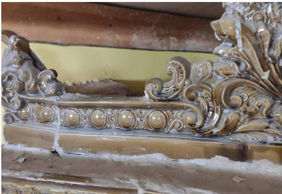
Рисунок 26 – Загрязнение поверхности изразцов пылью
