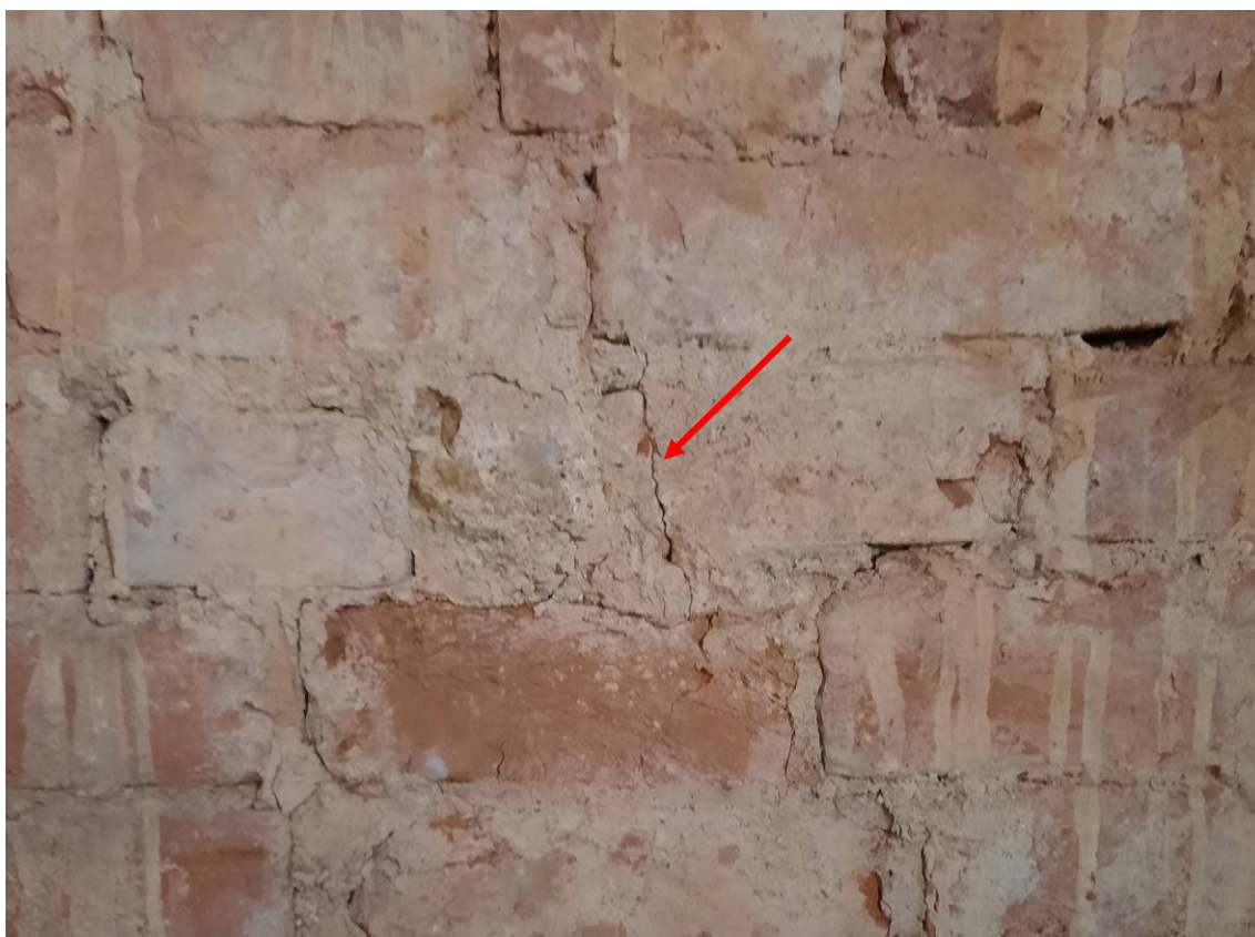
Рисунок 21 – Трещина в кладке стены
