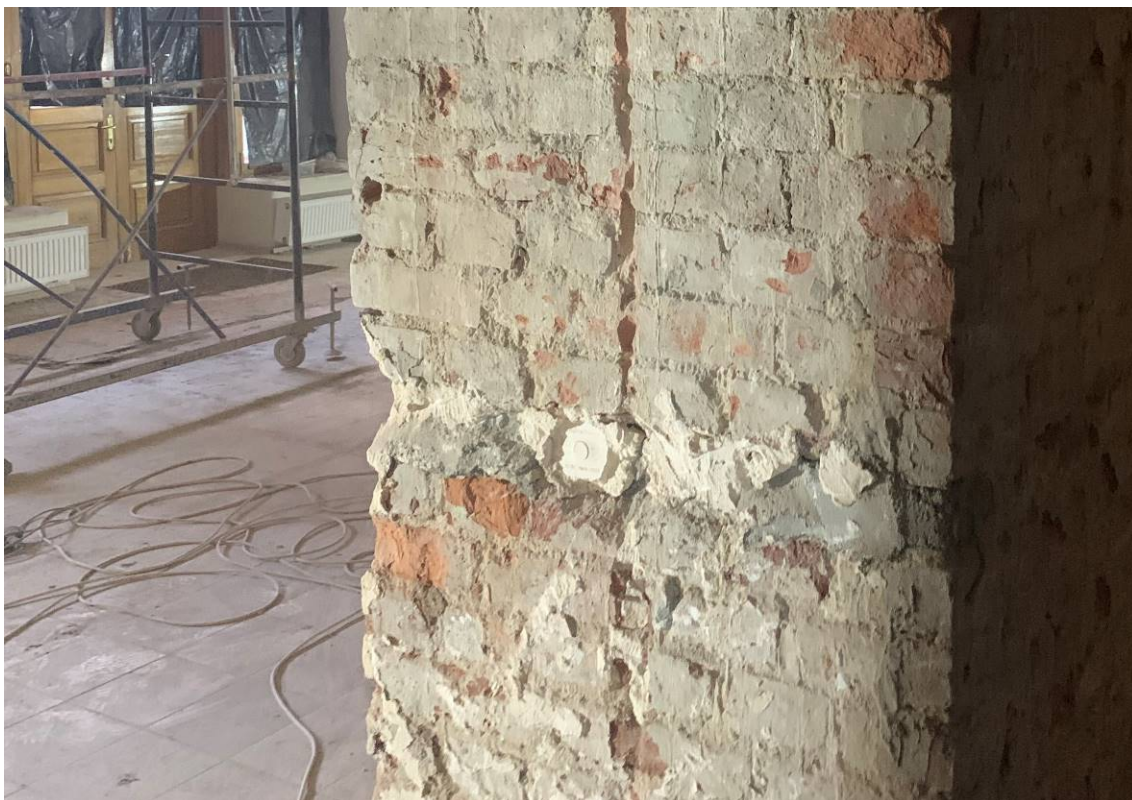
Рисунок 18 – Докомпановки утрат кирпича из гипсового и цемент содержащего растворов, выполнены неаккуратно
