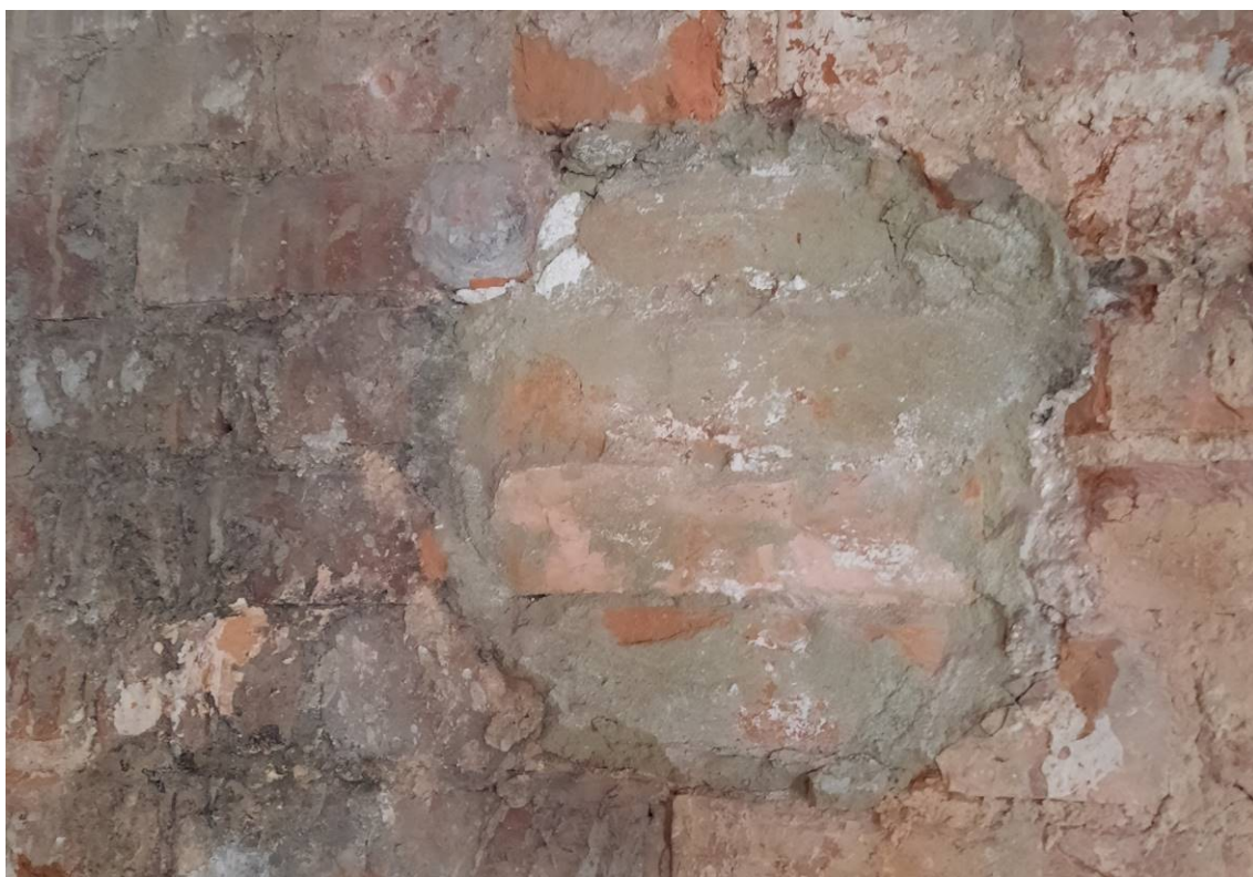
Рисунок 17 – Восполнение крупных утрат кладки путем вставки из керамического кирпича без перевязки, ремонтная обмазка цемент содержащим раствором
