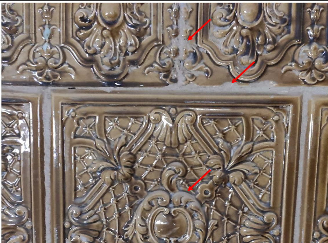
Рисунок 28 – Загрязнение поверхности изразцов пылью и строительными растворами
