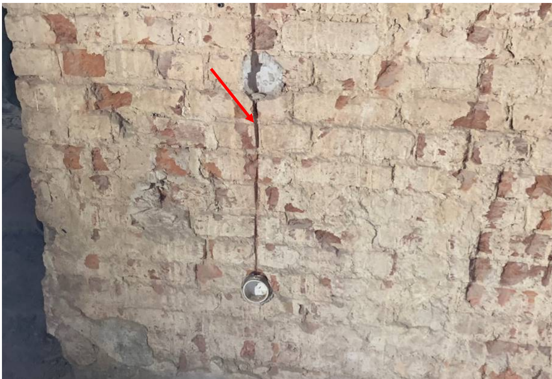
Рисунок 7 – Мелкие утраты кирпича вследствие устройства штробы
