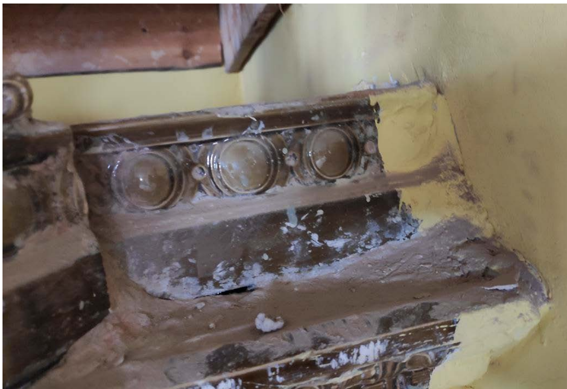
Рисунок 30 – Загрязнение поверхности изразцов пылью, строительными растворами и лакокрасочными составами
