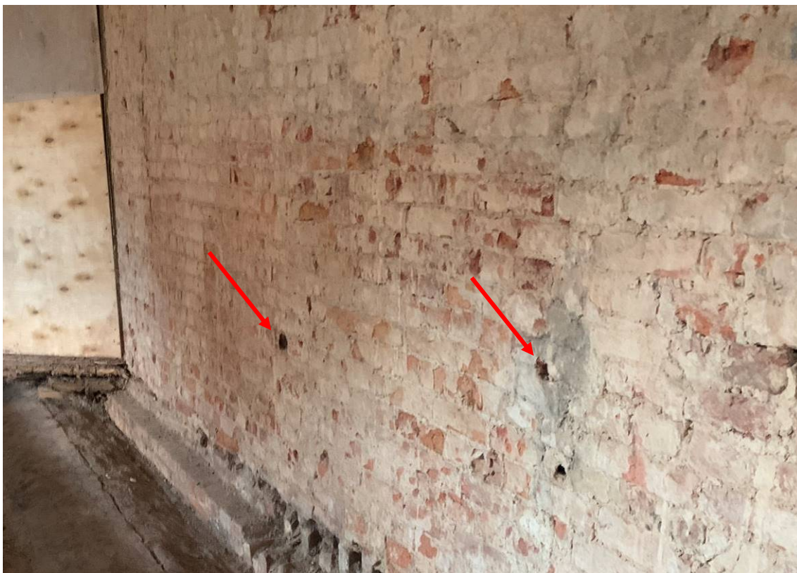
Рисунок 8 – Мелкие утраты кирпича в виде отверстий
