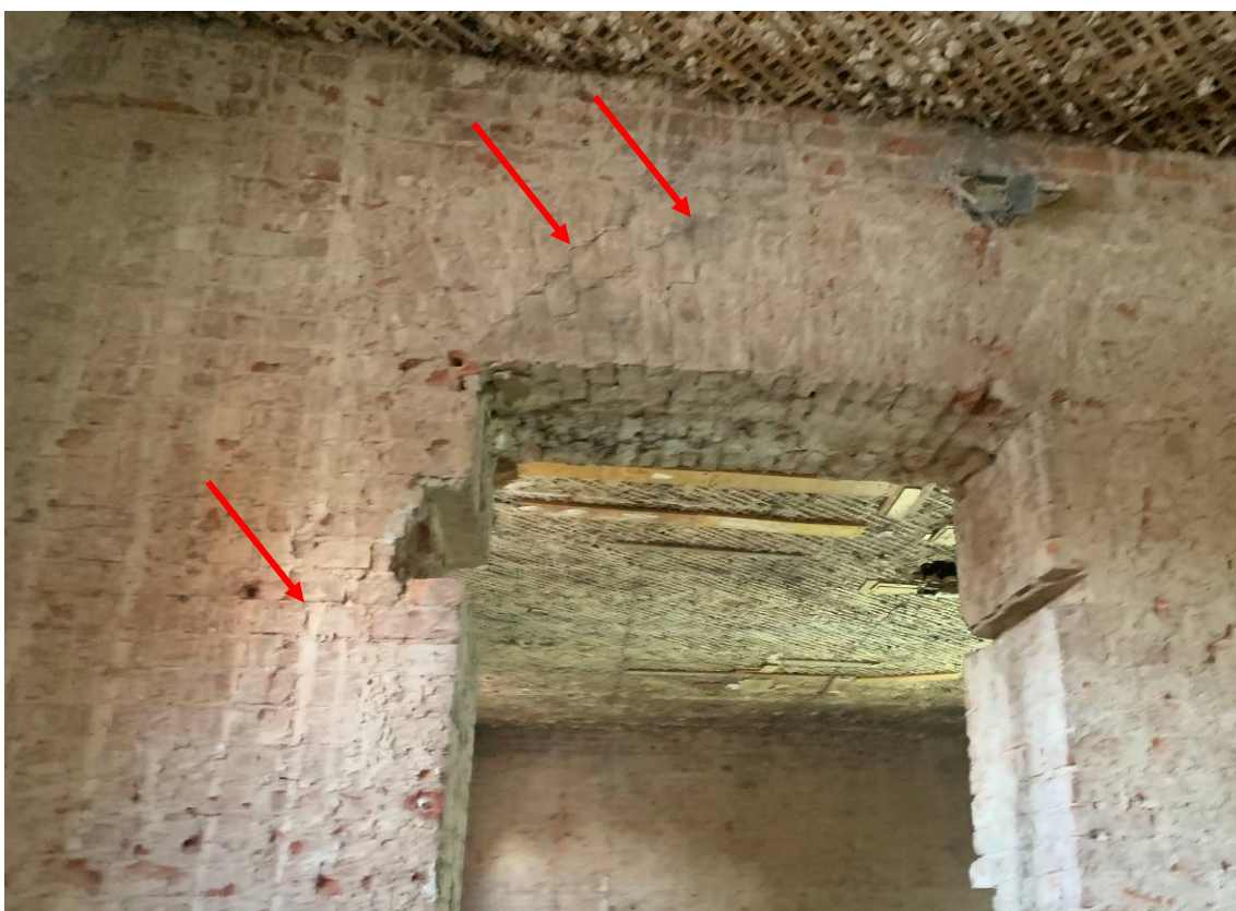
Рисунок 19 – Трещины в кладке стены вблизи проема
