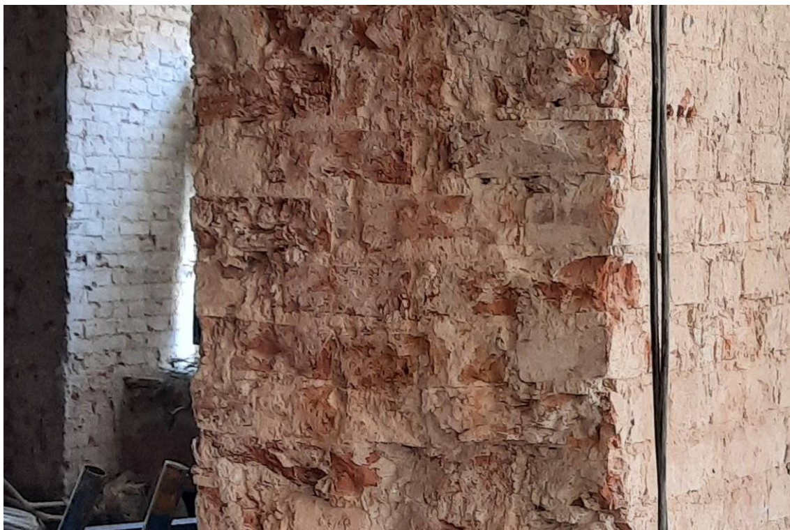
Рисунок 3 – Деструкция кирпича кладки проема, утрата поверхностного слоя кирпича до \frac{1}{4} глубины
