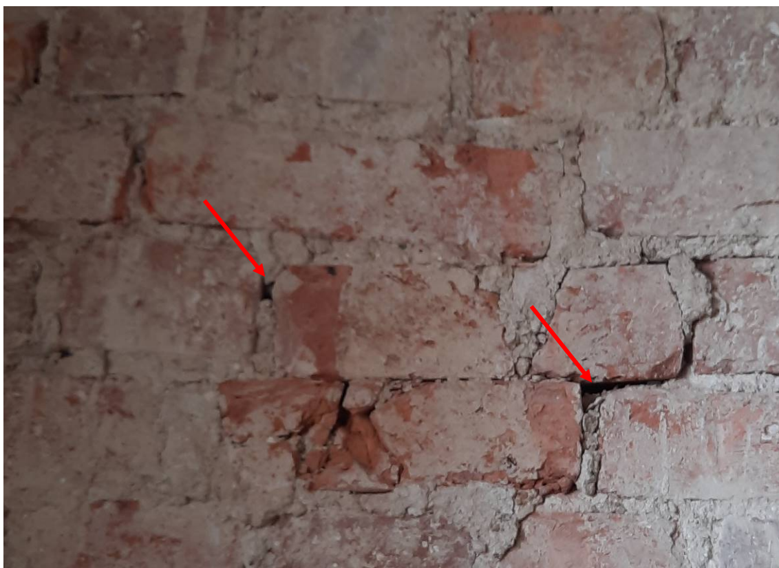
Рисунок 9 – Утраты шовного раствора, деструкция и мелкие утраты кирпича
