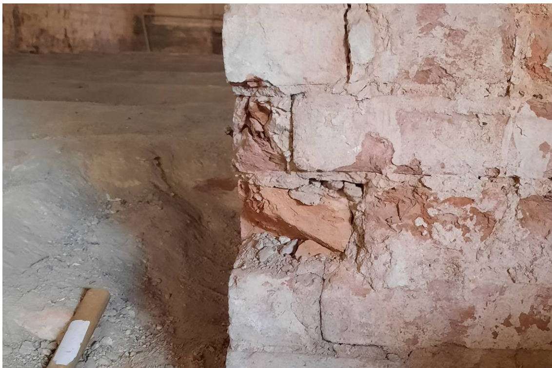
Рисунок 4 – Деструкция кирпича, образование утрат кирпича до 1/3 глубины
