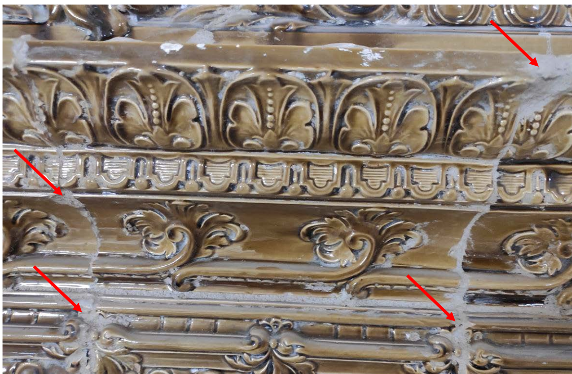
Рисунок 36 – Неаккуратное заполнение швов, докомпановки утрат цемент содержащими растворами
