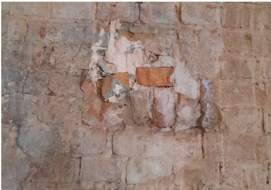
Рисунок 16 – Восполнение крупных утрат кладки путем вставки из керамического кирпича без перевязки, докомпановка утрат гипсовым раствором
