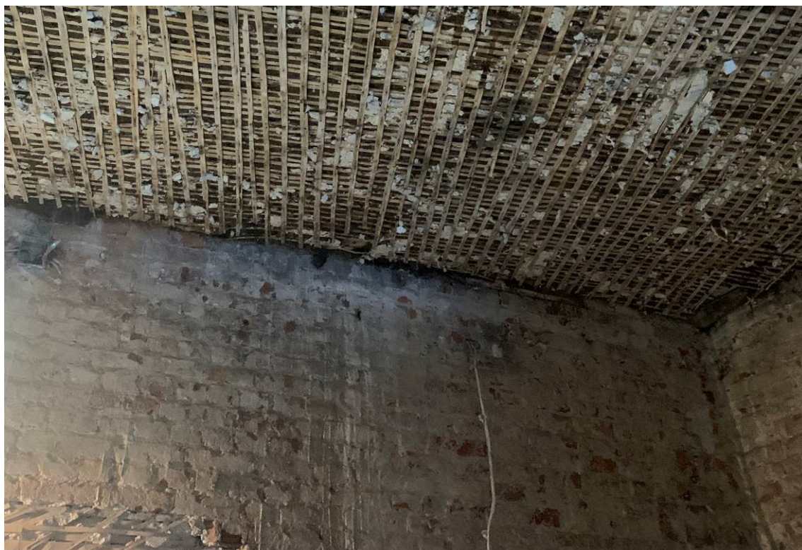
Рисунок 23 – Высолы на поверхности кирпича
