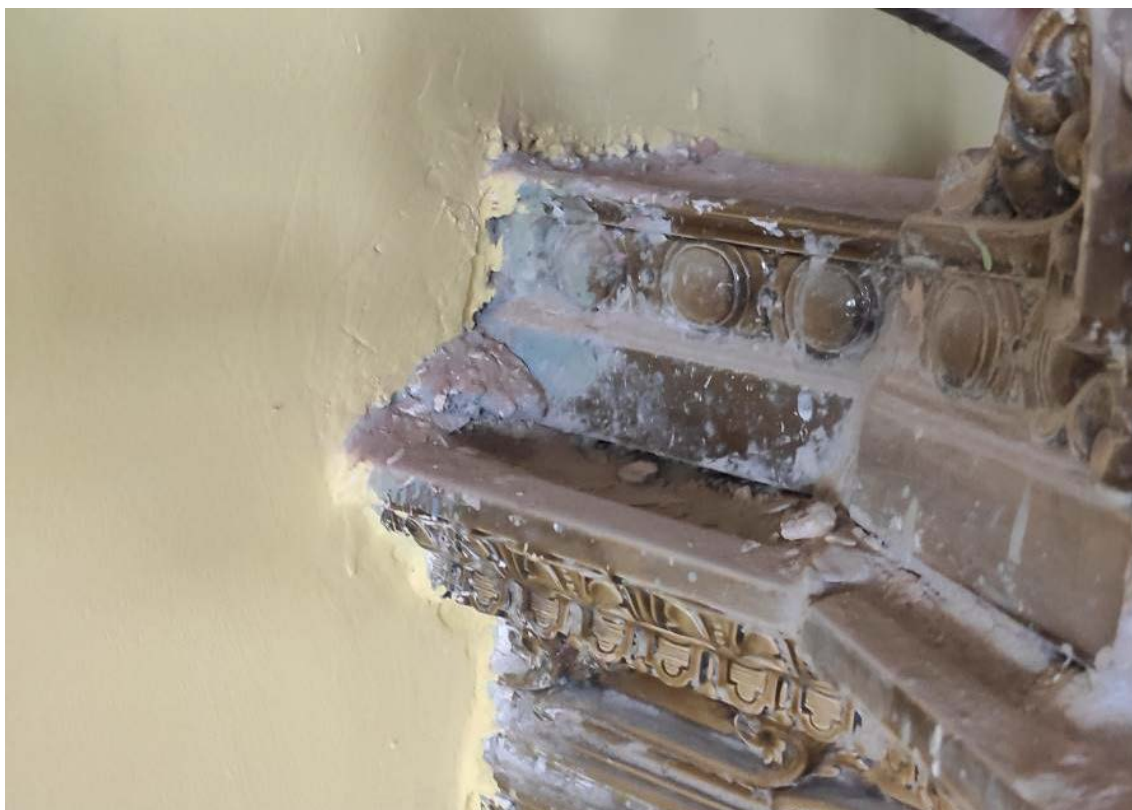
Рисунок 29 – Загрязнение поверхности изразцов пылью, строительными растворами и лакокрасочными составами
