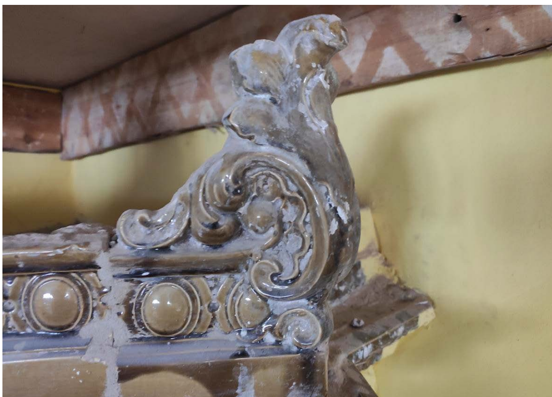
Рисунок 27 – Загрязнение поверхности изразцов пылью и строительными растворами
