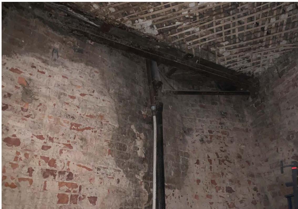
Рисунок 24 – Участок чрезмерного увлажнения кирпичной кладки, развитие биопоражений с образованием биопленок, предположительно, с преобладанием грибов
