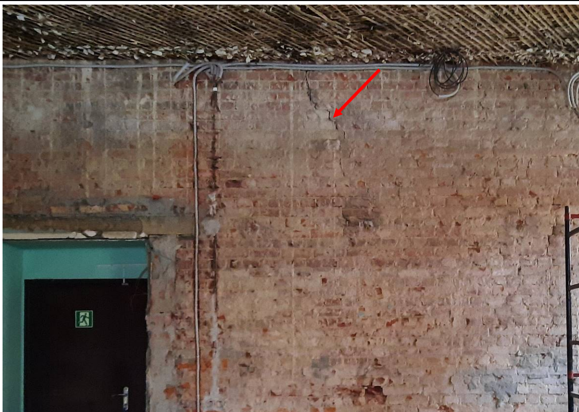
Рисунок 20 – Трещина в кладке стены
