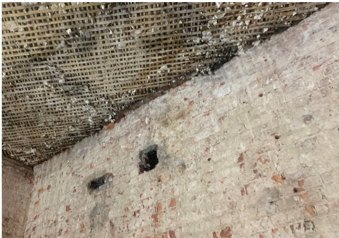
Рисунок 22 – Высолы на поверхности кирпича
