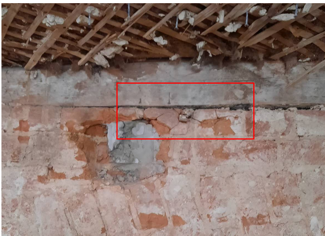
Рисунок 5 – Деструкция кирпича, трещины
